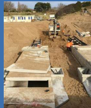
A chaque kilomètre, une tranchée pour les chambres de jonction.
