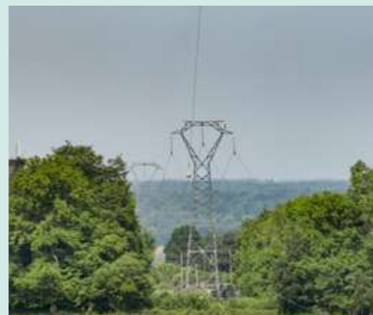
TRANCHÉE DE 60 MÈTRES DE LARGE
