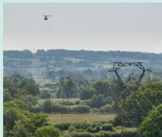
TRANCHÉE DE 80 MÈTRES DE LARGE
