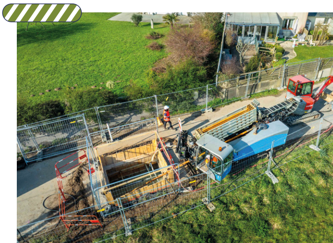
Réalisation du forage dirigé, pour le passage de la liaison électrique souterraine.
