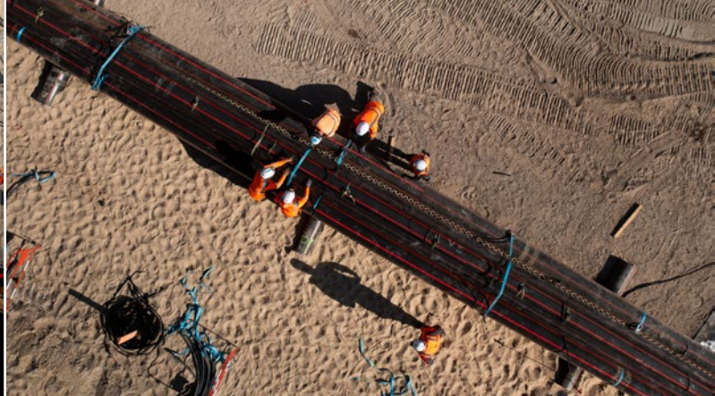
2 Forage dirigé sous la Dordogne (terminé en février 2025). Le forage sous la Garonne est en cours et se terminera en septembre.
