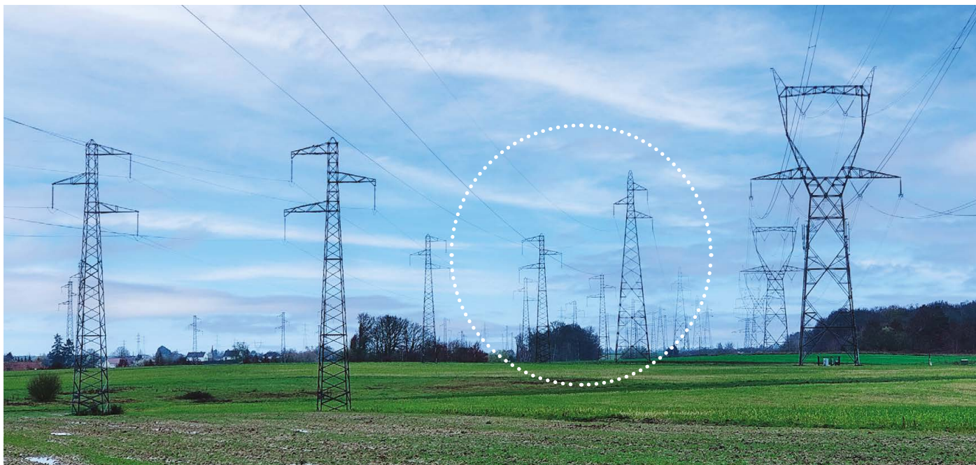
Dans le couloir de lignes électriques entre Chaingy et Dambron, l'implantation de la future ligne à 400 000 volts est envisagée en lieu et place de deux des trois lignes à 225 000 volts qui seront supprimées.
