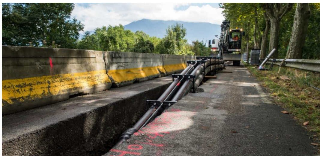
Déroutage d'une liaison souterraine
