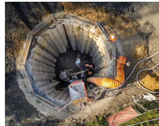
Le micro-tunnelier en action à Kerfaven.
