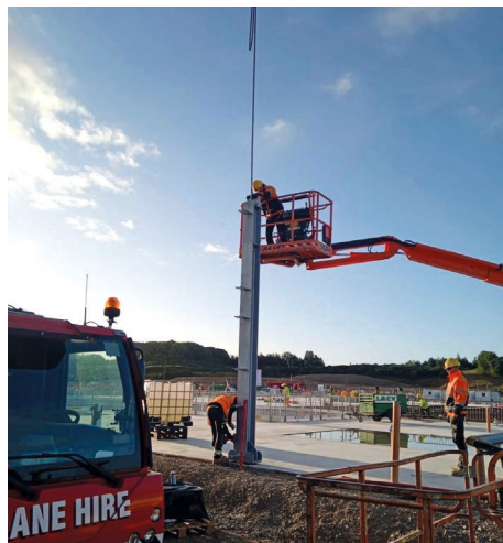
Assemblage des structures en acier du bâtiment qui abritera la station de conversion, dans la ville de Ballyadam, à l'est de Cork.
