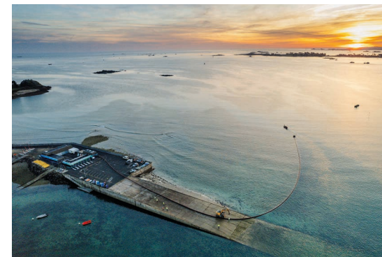
Après avoir été assemblé, le premier fourreau est mis à l'eau à Saint Pol-de-Léon pour rejoindre le lieu d'atterrage à Cléder.
