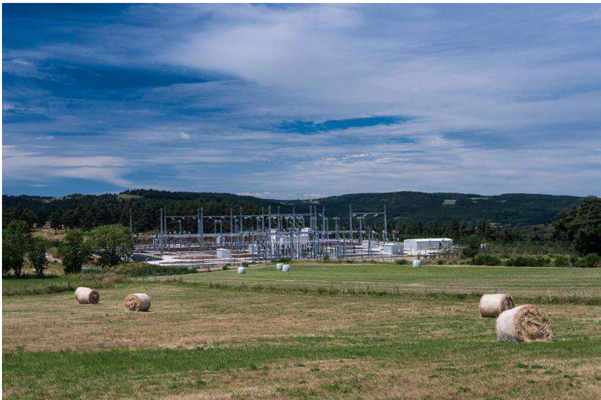
Vue du poste 225 000 volts de MONTGROS (Lozère)
