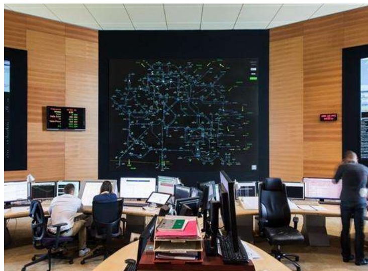
Salle de téléconduite (dispatching) du réseau RTE
