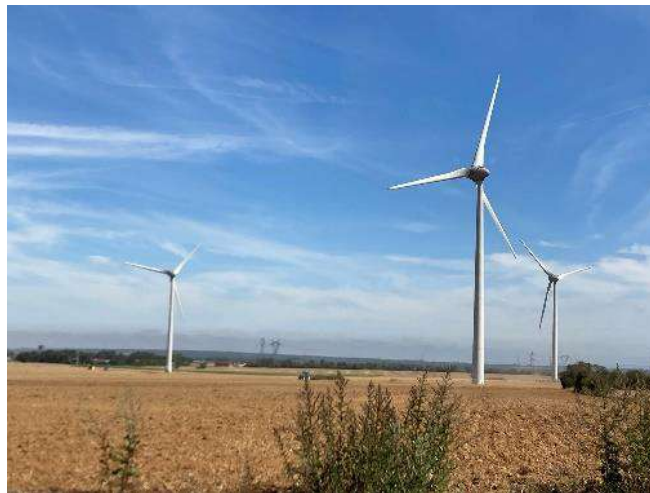
Figure 55 : Parc éolien de Frénoville (EGIS, 2022)
