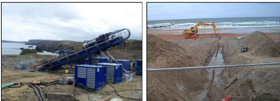
Figure 15 : Exemple de pose de liaison sous-marine via forage dirigé (à gauche) ou tranchée (à droite) sur l'estran* (RTE, 2021)
