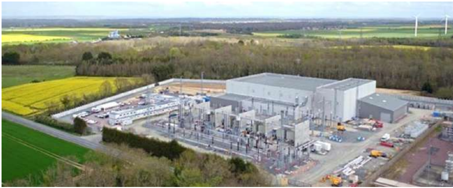
Figure 20 : Exemple de la station de conversion IFA2 (Bellengreville, Calvados - 14) 320 000 Volts courant continu / 400 000 Volts courant alternatif (RTE, 2021)
