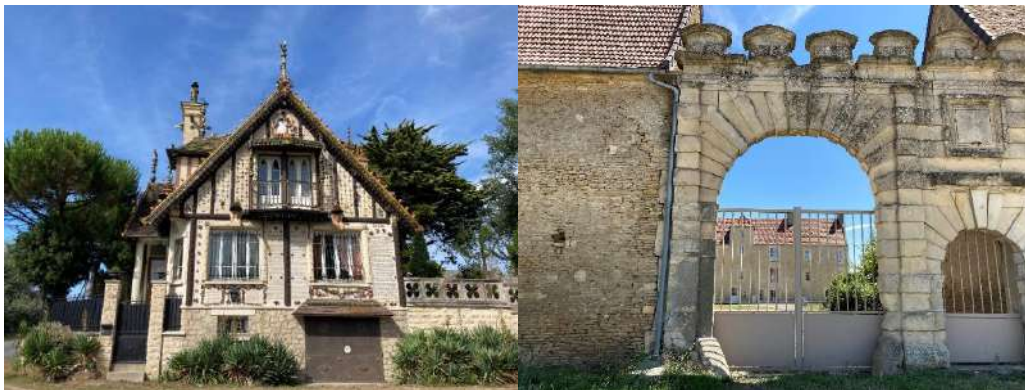
Figure 58 : Manoirs à Colleville-Montgomery (à gauche) et Émiéville (droite) (EGIS, 2022)
