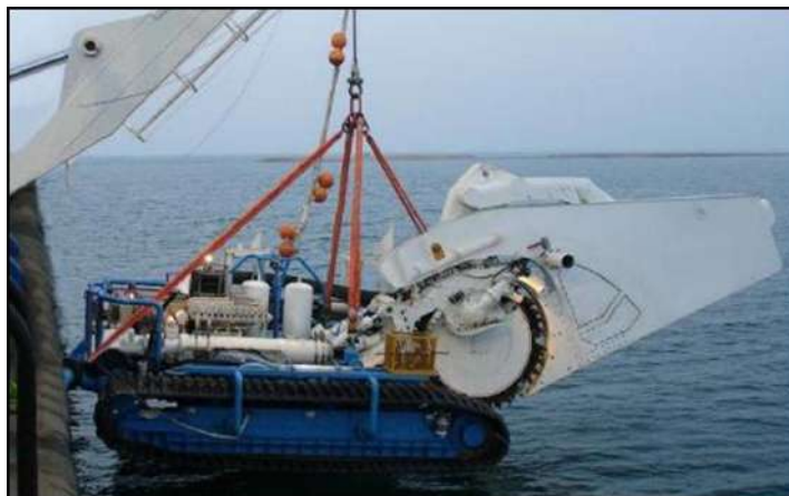
Figure 13 : Trancheuse mécanique à roue (RTE, 2021)
