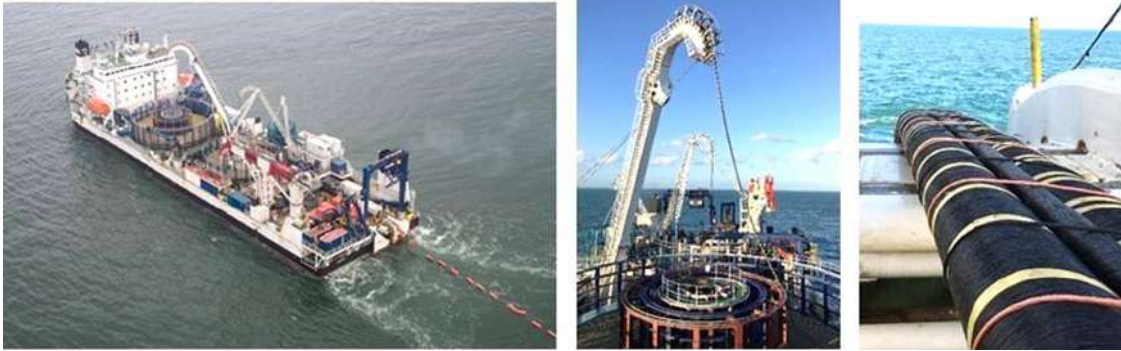
Figure 10 : Pose d'un câble sous-marin par un navire câblé (RTE, 2021)
