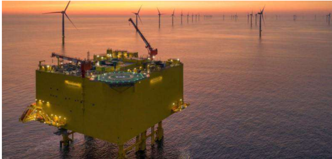
Figure 6 : Exemple de plateforme en mer 320 000 Volts courant continu (Siemens, BorWin3)
