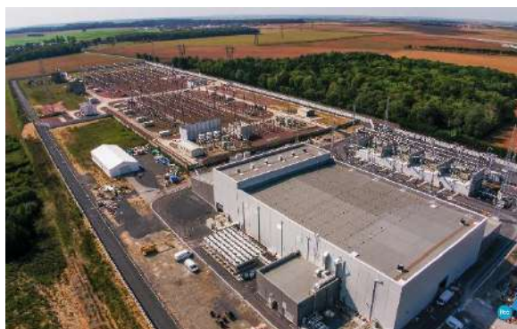
Figure 21 : Vue aérienne sur le poste de Tourbe 400 000 Volts (EGIS, 2022)
