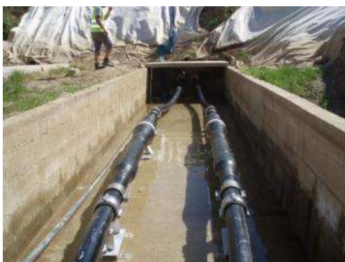
Figure 19 : Chambre de jonction sous voiries (RTE, 2021)
