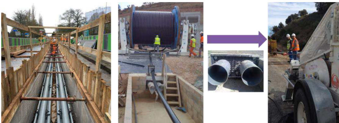
Figure 17 : Pose d'une liaison souterraine sous voiries (RTE, 2021)
