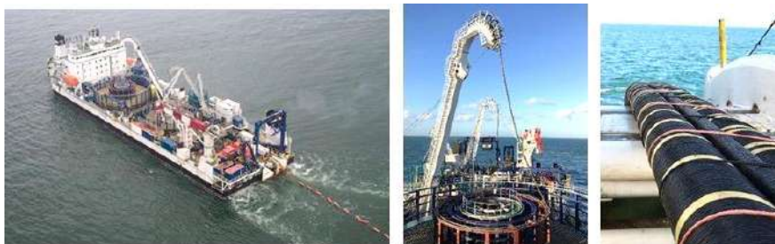
Pose d'un câble sous-marin par un navire câblé
