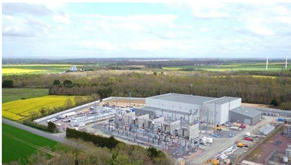
Exemple d'une station de conversion 320 kV continu / 400 kV alternatif
