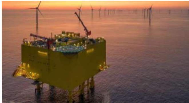
Exemple de poste électrique en mer 320 kV continu (source : Siemens, BorWin3)
