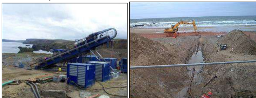
Forage dirigé (à gauche) ou Tranchée sur l'estran (à droite)
