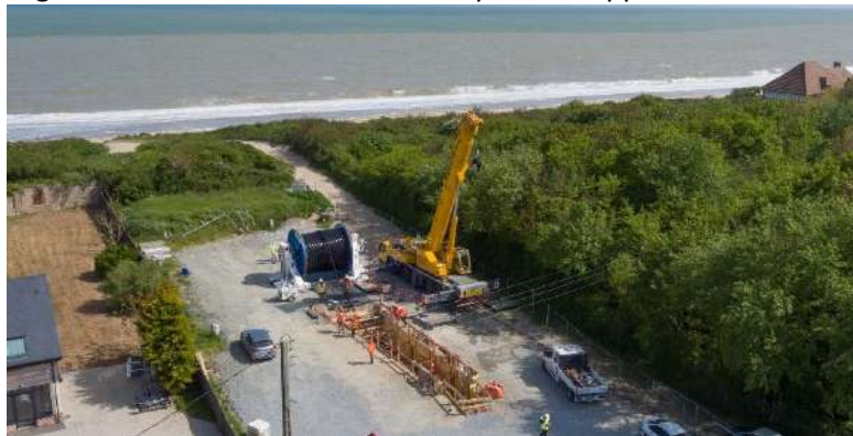
Exemple d'une chambre de jonction d'atterrage avant comblement (Interconnexion France-Angleterre IFA2)
