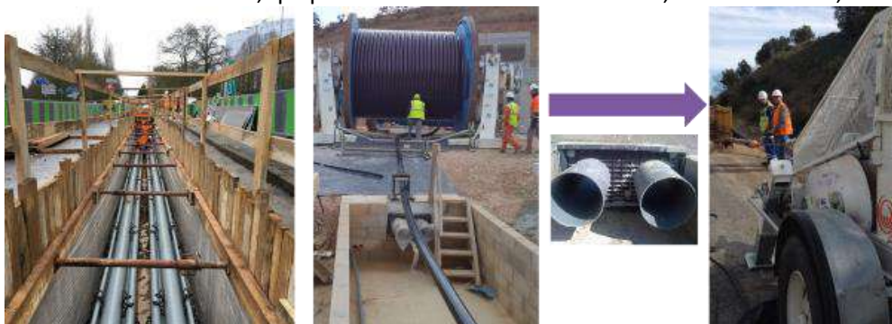
Pose de liaison souterraine sous de voirie
