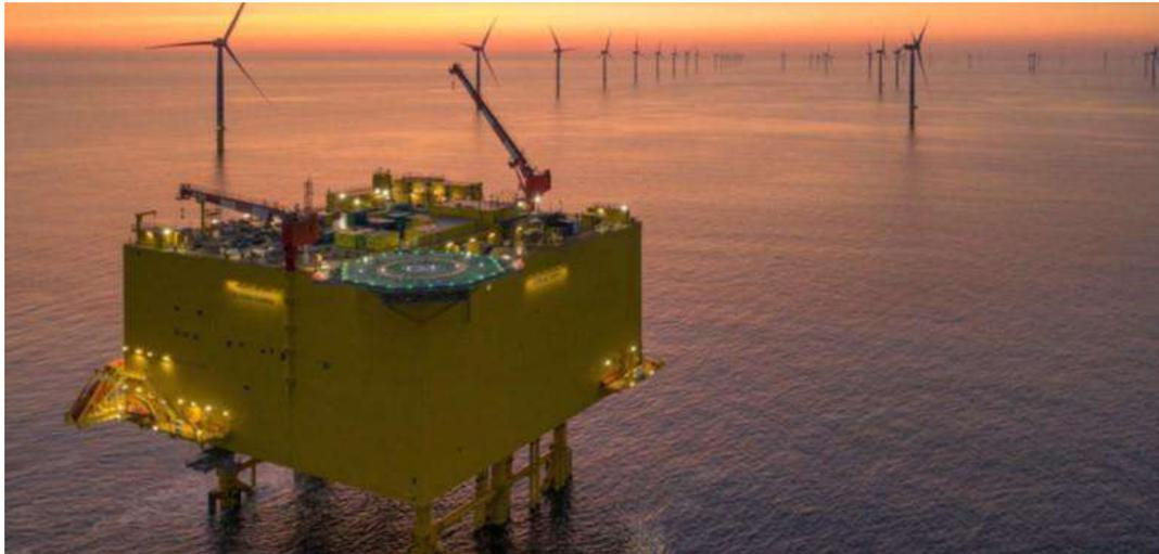
Figure 6 : Exemple de plateforme électrique en mer 320 000 Volts courant continu
