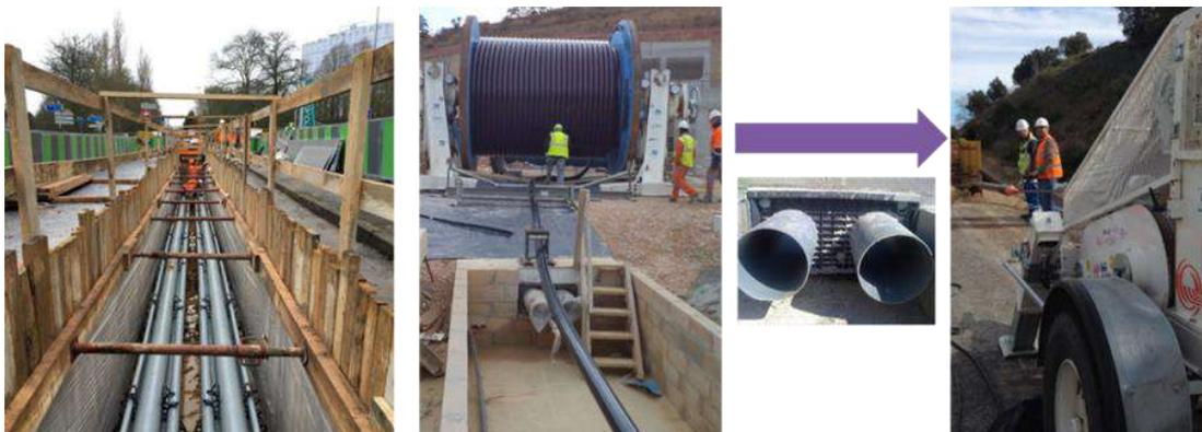
Figure 20 : Pose d'une liaison souterraine sous voiries (source : RTE, 2021)
