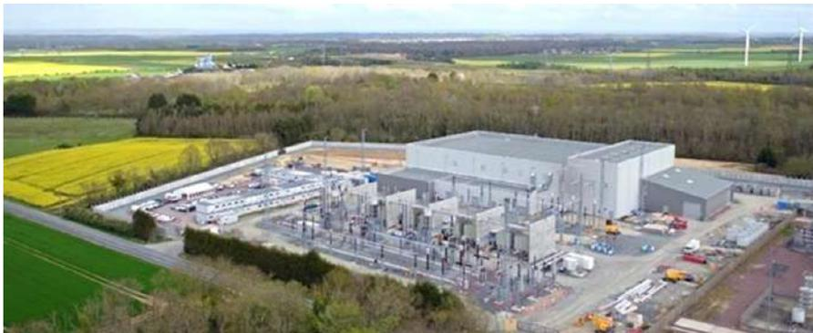
Figure 25 : Exemple de la station de conversion terrestre IFA2\* (Bellengreville, Calvados - 14) 320 000 Volts courant continu / 400 000 Volts courant alternatif (source : RTE, 2021)
