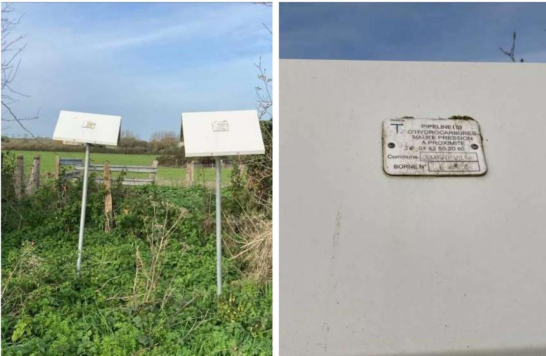
Figure 94 : Balises blanches indiquant la présence d'une canalisation d'hydrocarbures (le réseau Trapil) (EGIS, 2022)
