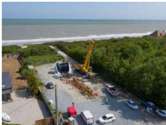
Figure 17 : Exemple d'une chambre de jonction d'atterrage avant comblement (source : Interconnexion France-Angleterre - IFA2)
