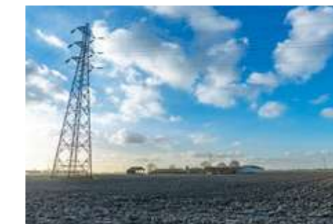
Figure 47 : Vue sur les plaines agricoles et corps de ferme (RTE, 2023)
