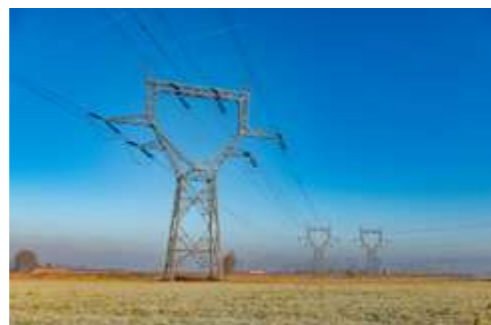
Figure 31 : Lignes et pylônes électriques traversant l'aire d'étude : Saint-Georges-sur-l'Aa (RTE, 2023)
