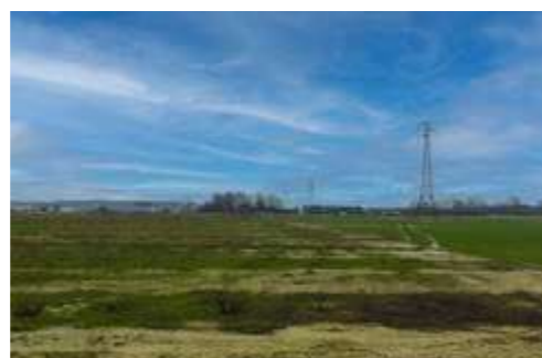
Figure 40 : Vue vers la ZAC Eurofret : Craywick (RTE, 2023)
