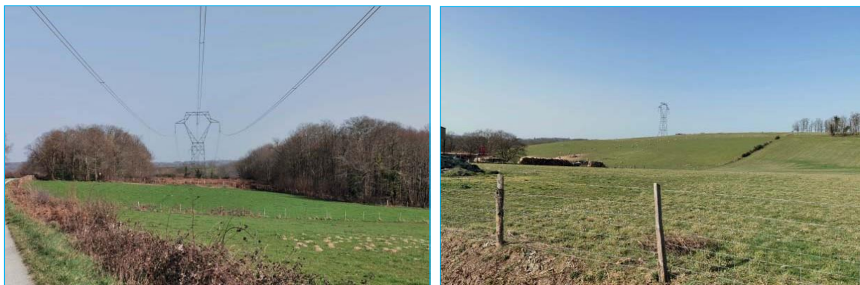
Physionomie de l'aire d'étude aux abords de la ligne aérienne à 400 000 volts existante
