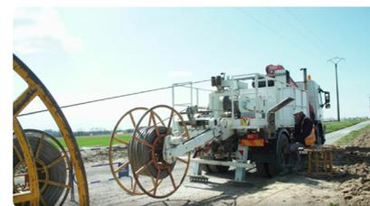
Le câble est tiré par un treuil installé 2 km plus loin.
