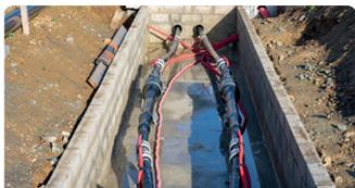
La chambre de jonction est un espace maçonné où les câbles électriques vont être soudés ensemble.
