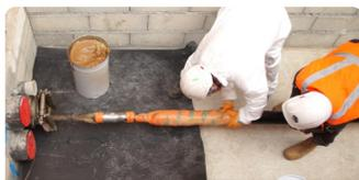
Le câble est graissé puis guidé à l'intérieur du tube en pvc.
