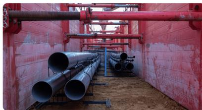
Dans les tranchées entre Fécamp et le poste de Sainneville-sur-Seine il y a deux liaisons électriques de 225 000 volts. Chaque liaison est composée de 3 câbles électriques et de 2 câbles de fibre optique.
