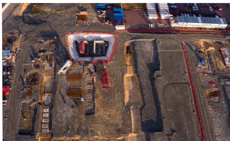
Vue aérienne de la station
