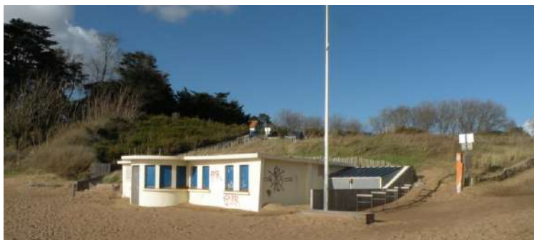
Figure 105 : Le poste de secours
