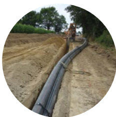
Installation de fourreaux dans un champ
