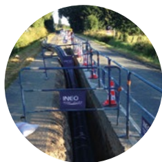
Installation de fourreaux sous la route
