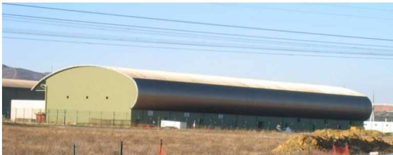
Exemple de la station de conversion de Baixas (proximité de Perpignan) (Source RTE)
