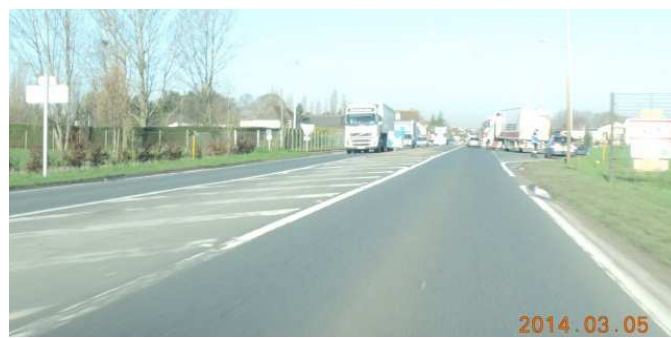
RD 613 au droit de Cagny
