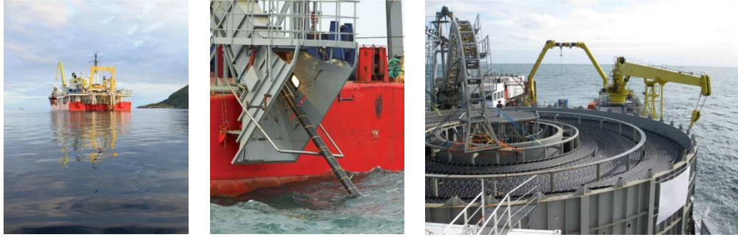
Navire câblé utilisé pour dérouler le câble en mer (Source RTE)
