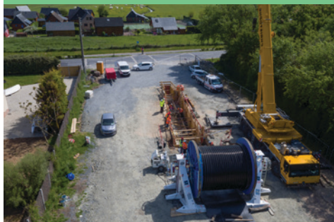
Déroutage des câbles de la liaison souterraine
