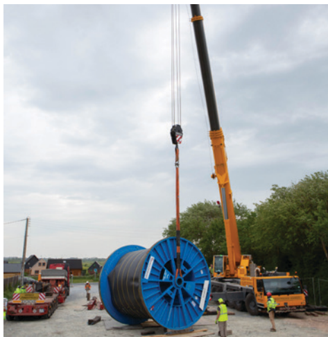
Déroutage des câbles de la liaison souterraine
