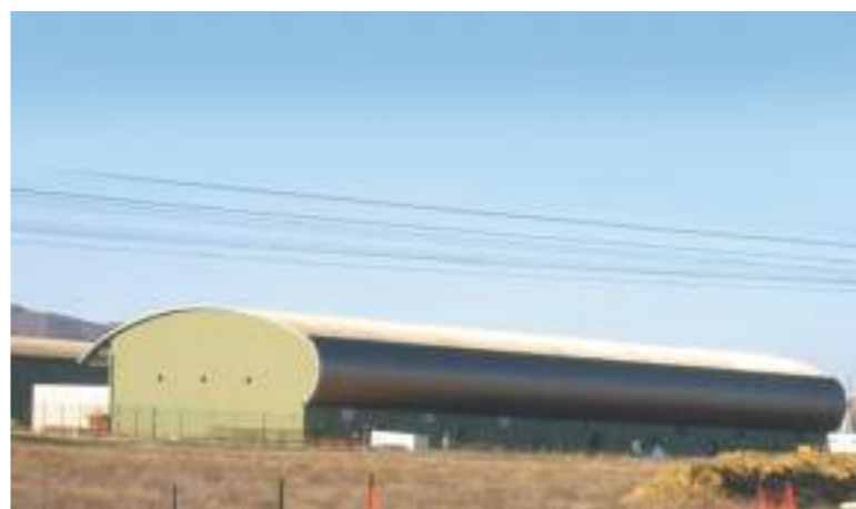
Exemple de station de conversion (Baixes, Pyrénées-Orientales)
