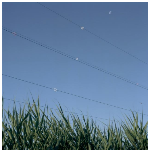
Câbles balisés par spirales colorées
