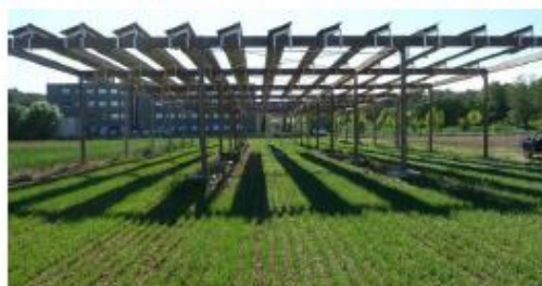
Exemple d'une installation agrivoltaïque
