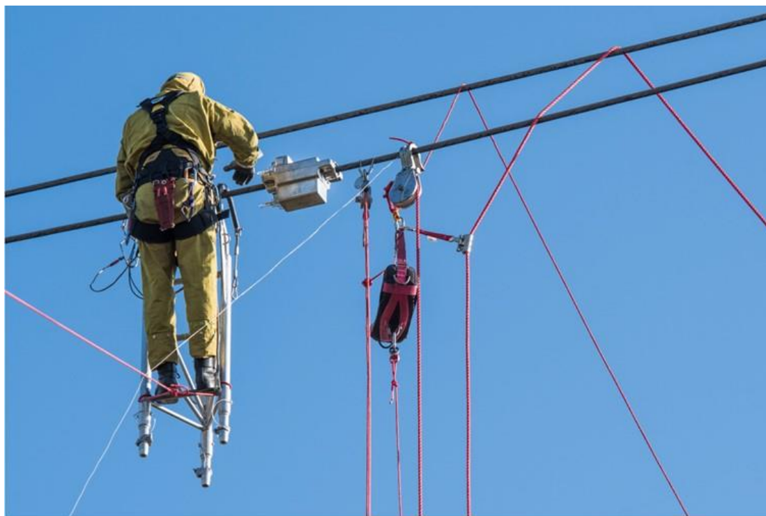
Pose de capteurs DLR sur une ligne haute tension (copyright Caroline Dutrey)
