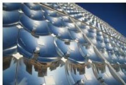
Champ photovoltaïque avec modules à concentration
