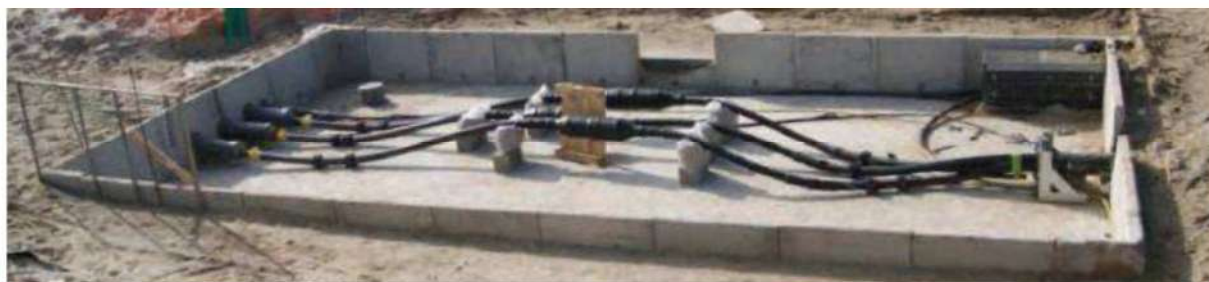
Photo 1 : Jonction d'atterrage (Nexans)
