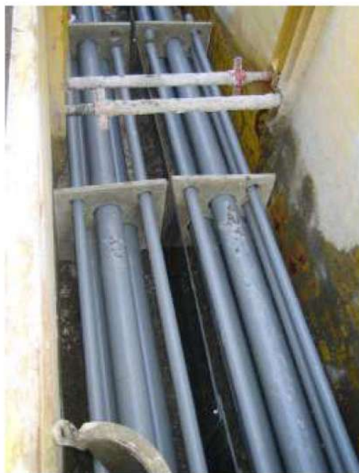
Photo 2 : Illustration d'une liaison souterraine à deux circuits sous voirie (RTE)
