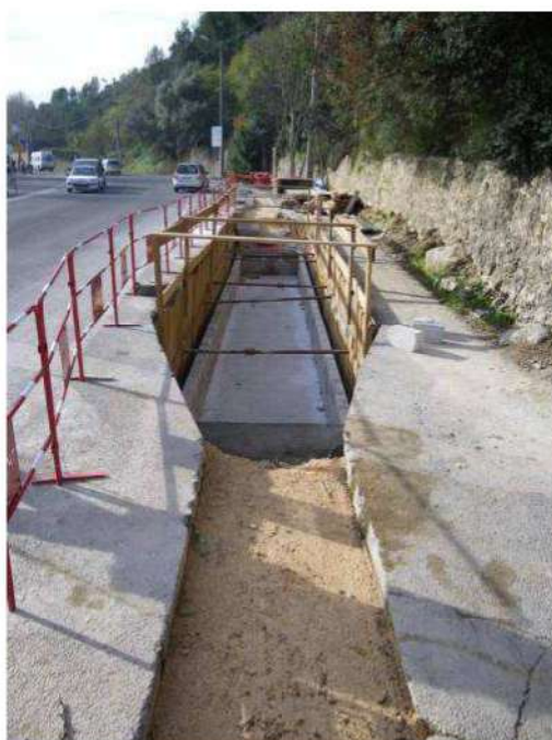
Photo 3 : Illustration d'une chambre de jonction d'une liaison souterraine d'un seul circuit 225 000 volts (RTE)
