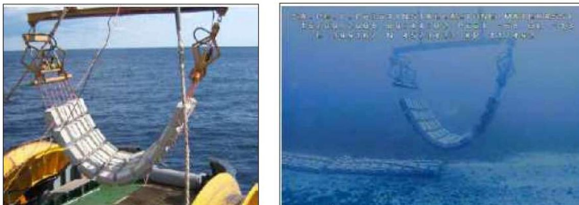
Figure 6 : Exemple de protection externe par matelas
