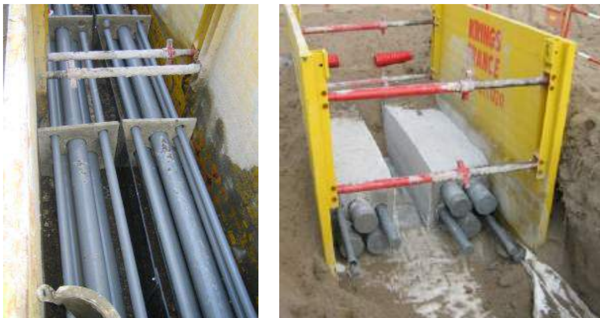
Figure 25 : illustration d'une liaison souterraine à deux circuits
