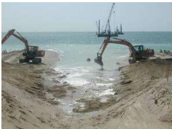
Figure 17 : exemple de tranchée ouverte sur la plage
