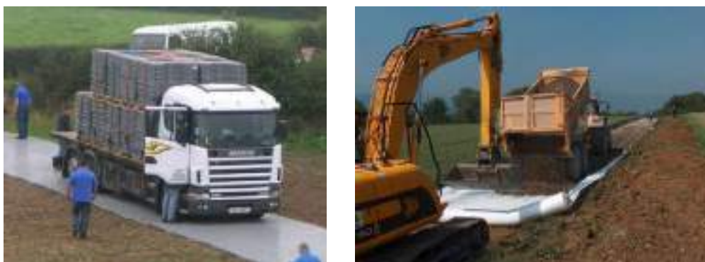
Figure 32 : exemples de pistes en « plaques » et en matériaux
