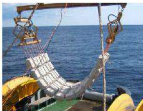
Figure 8 : exemple de protection externe par matelas
