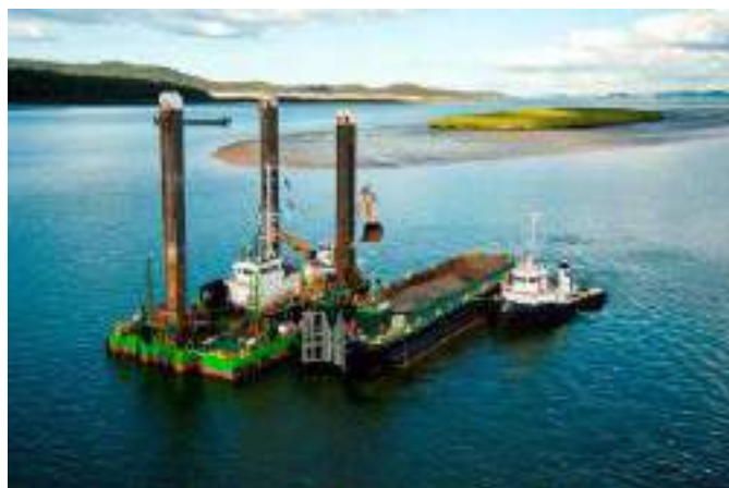
Figure 14 : exemple de pelle rétro-caveuse, ici avec navire sablier et remorqueur
