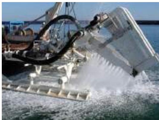
Figure 13 : exemple de water jetting
