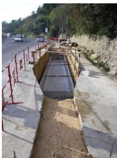
Chambre de jonction avant que la chaussée ne soit reconstruite
